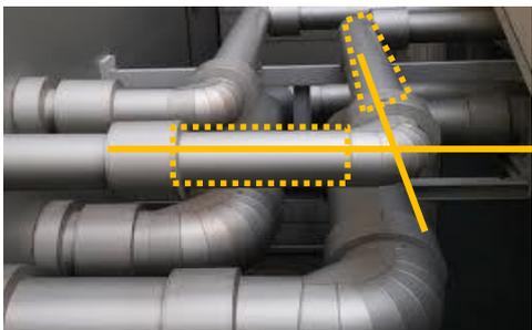
図1 周囲の構成物からの軸の推定
