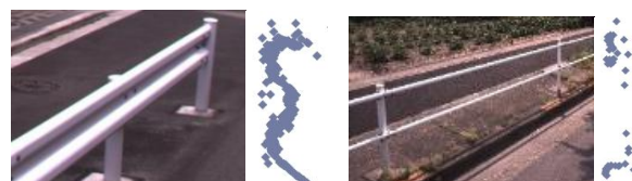
図 6 ガードレール（左）とガードパイプ（右）の点群の投影（左）
