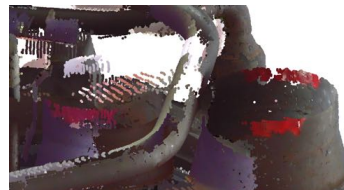
(c)例題 1: 配管上部の点の欠落
